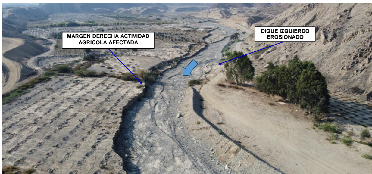
FIGURA N°03: RIO OISQUILLO ORCÓN, SECTOR PUMAHUACA CON LOS DIQUES DE AMBOS LADOS EN ESTADO DE EROSION AVANZADA, CAUSE COLMATADO DE FLUJO DE DETRITOS Y AREAS DE CULTIVO EN LA MARGEN DERECHA AFECTADO.
