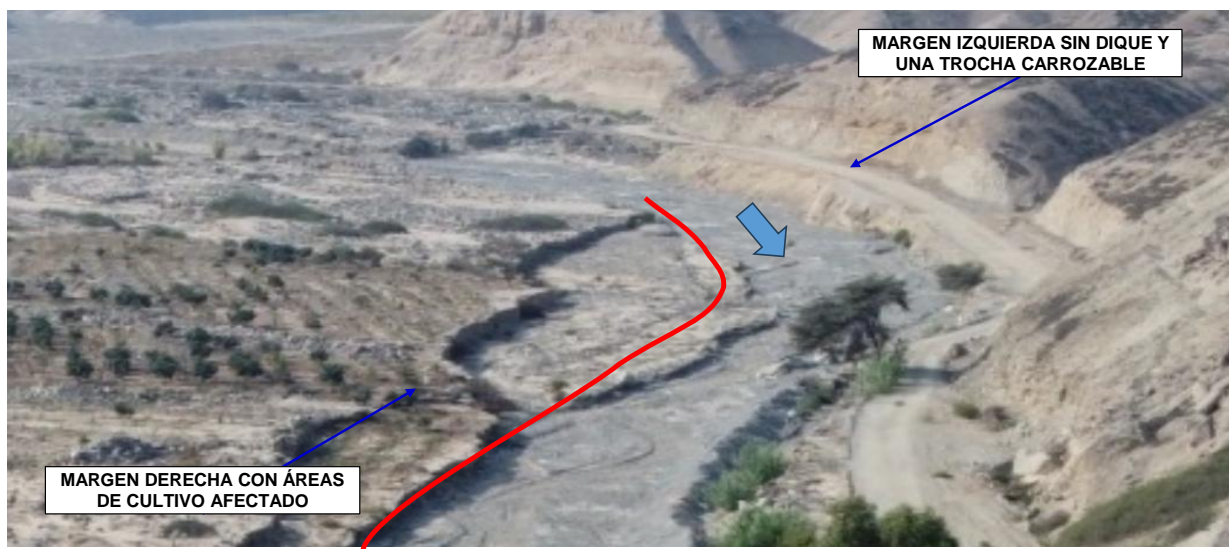
FIGURA N°02: RIO PISQUILLO ORCÓN, SECTOR PISQUILLO CON DIQUES EROSIONADOS EN AMBOS LADOS DEL CAUCE, A SU VEZ EL CAUCE SE ENCUENTRA MUY COLMATADO POR FLUJO DE DETRITOS.
