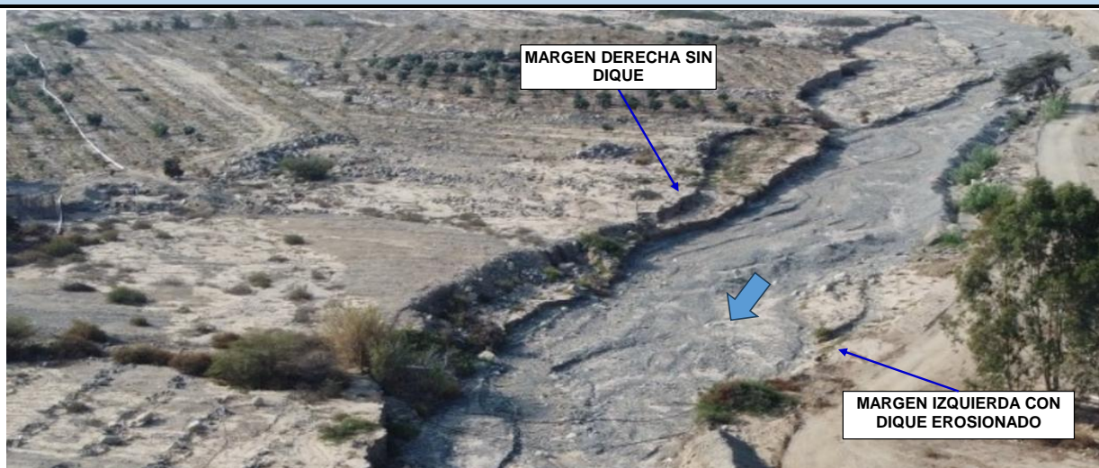
FIGURA N°01: RIO PISQUILLO ORCÓN, SECTOR PUMAHUACA CUYOS DIQUES EN AMBOS LADOS DEL CAUCE EL DIQUE SE ENCUENTRA EN ESTADO DE EROSION AVANZADA Y EN OTRO TRAMOS NO EXISTEN.
